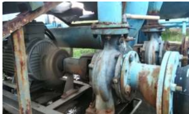
Gambar 1. Pompa sentrifugal
