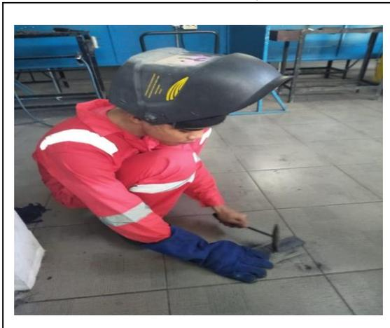
Gambar. 3.3 Proses Pengelasan Sudut Kampuh V
